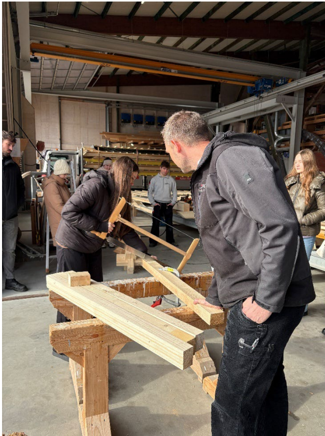
Das Sägen eines Balkens gehört zur Grundausbildung der Zimmerleute bei Holzbau Höfer.
